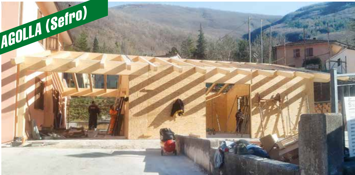
Gli ultimi lavori in ordine di tempo sono nella frazione di Agolla, nel Comune di Sefro dove è in cotruzione una casetta destinata alla comunità.
